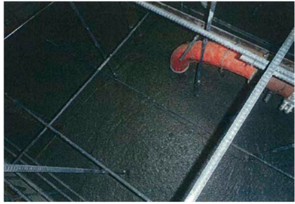
(d) Casting concrete using pipe
