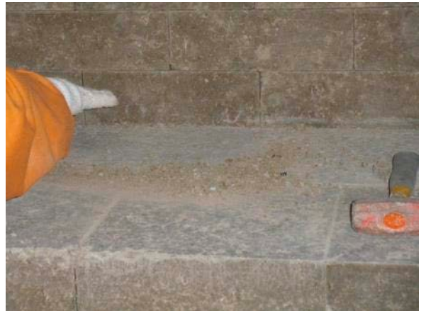
(d) After infilling a cable
