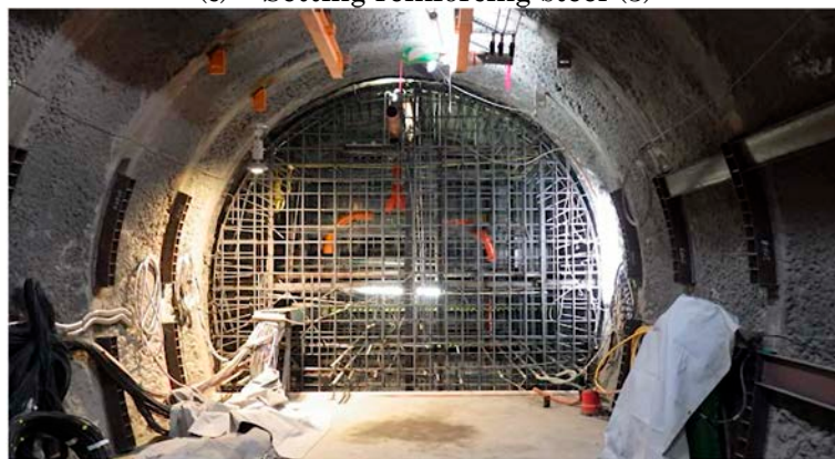
(d) Setting reinforcing steel (4)
